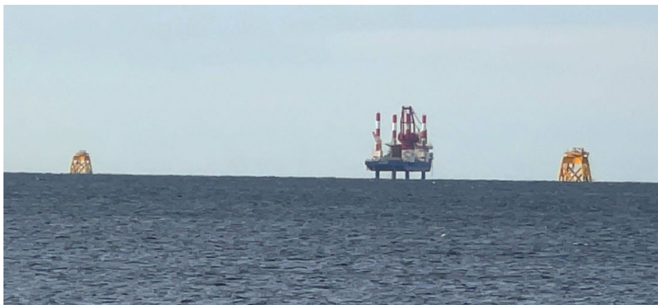
北九州市響灘地区では、着床式洋上風力の建設が進捗(11 月 25 日撮影)。中央は、杭打ち、クレーン作業等の自己昇降式台船(SEP 船)。両隣は着床式洋上風力の土台部分(ジャケット)。
